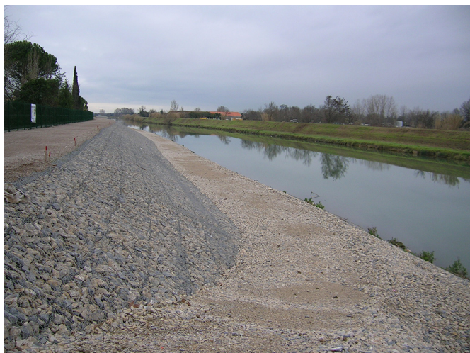
Fig. 2. La digue de Lattes.
