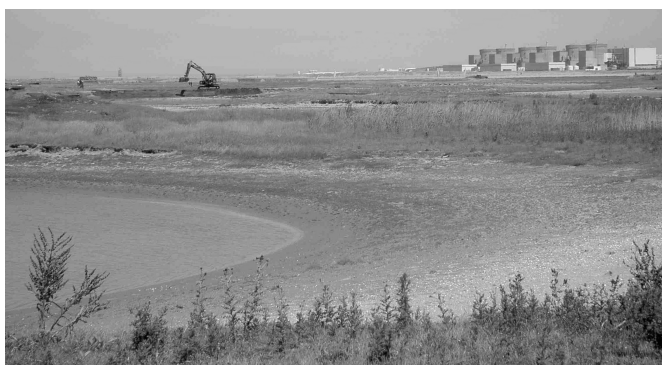
Fig. 2. Travaux d'entretien d'une mare par engins lourds, 2004. (Photo : Michel Delsaut.)
